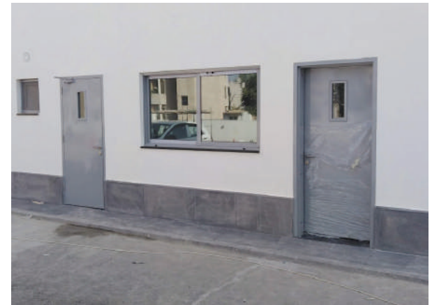
Hino Project (Metal Works)
